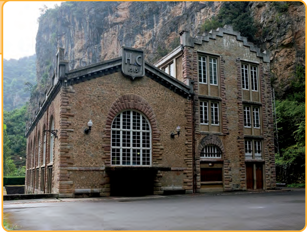
Fotografía Edificio de turbinas de la central minihidráulica de La Malva (Somiedo)
